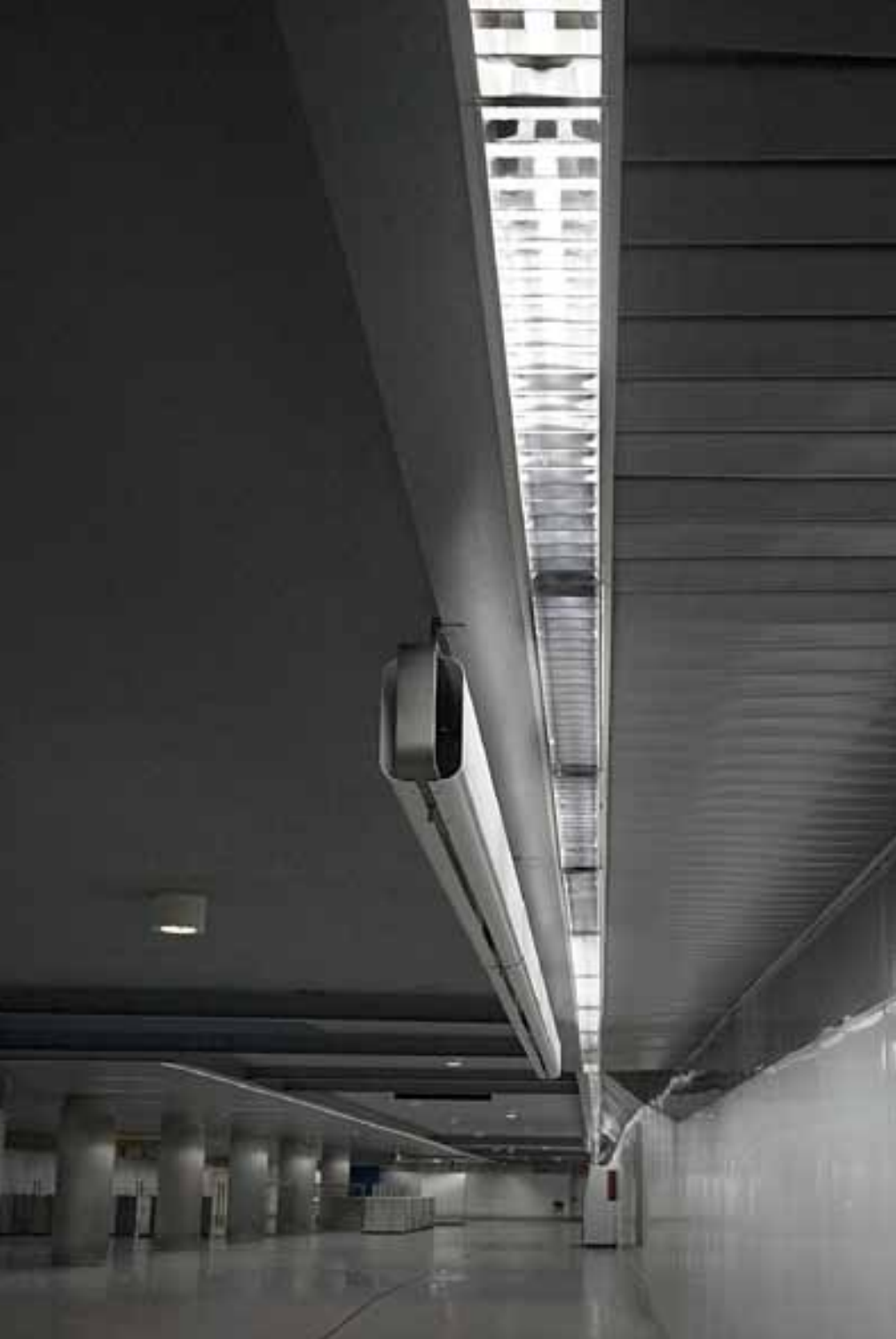
Estación de metro Bailén, Valencia (España)
