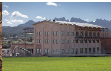
Recuperació edifici La Catalana a Manresa
