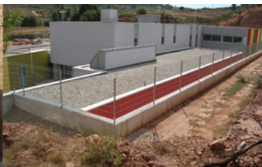
Construcció CEIP Ametllers de Sant Joan de Vilatorrada
