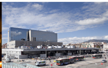
Instal·lacions de l'Estació de Sants a Barcelona
