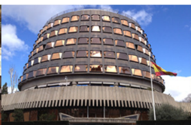
Sistema de detecció i prevenció d'incendis al Tribunal Constitucional a Madrid
