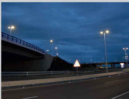
Acceso Puente Cádiz. Cádiz Túneles e infraestructuras
