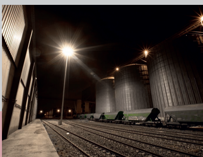
Puerto de Tarragona. Tarragona Túneles e infraestructuras
