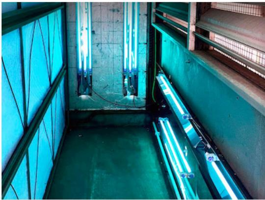
Instalación de generadores de UV-C en la cámara de filtros.
