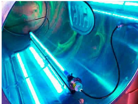
Instalación de generadores de UV-C en los conductos; si es necesario se instalan tapas de registro para facilitar el montaje y el mantenimiento.
