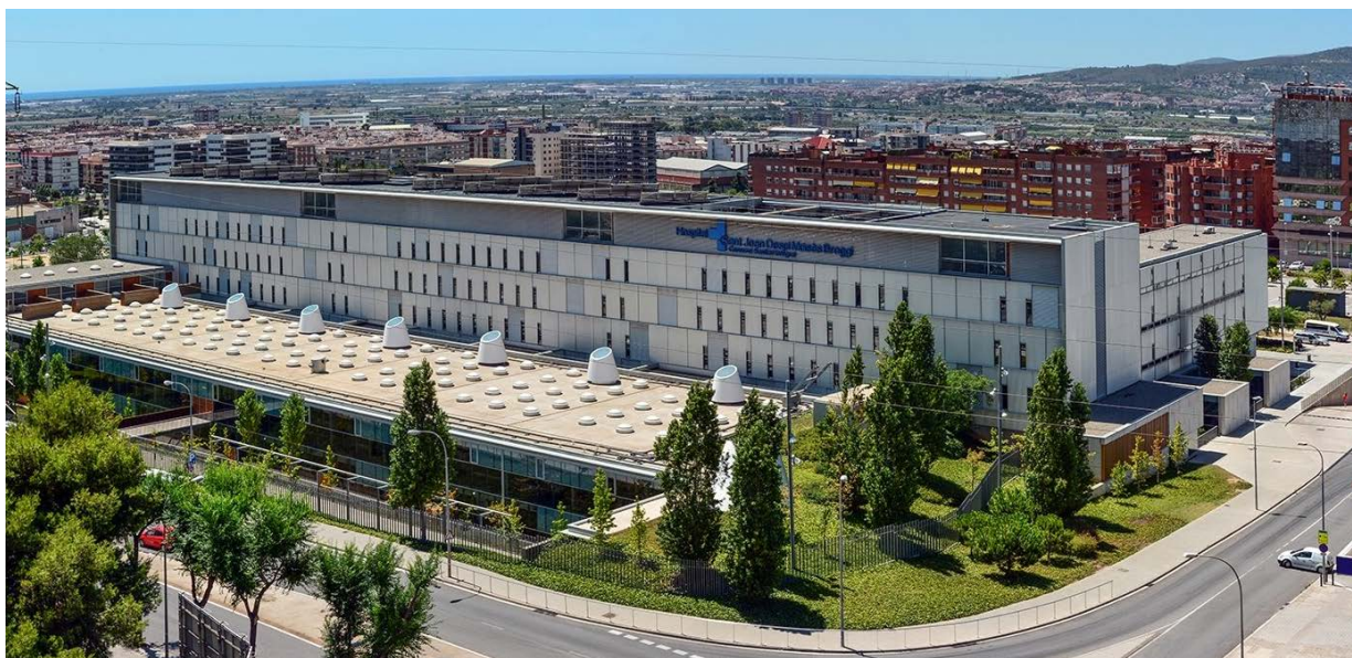
Hospital Moisès Broggi – 675 unit. FCU
