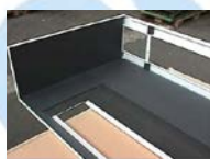
Aislamiento interior de 5/10 mm
